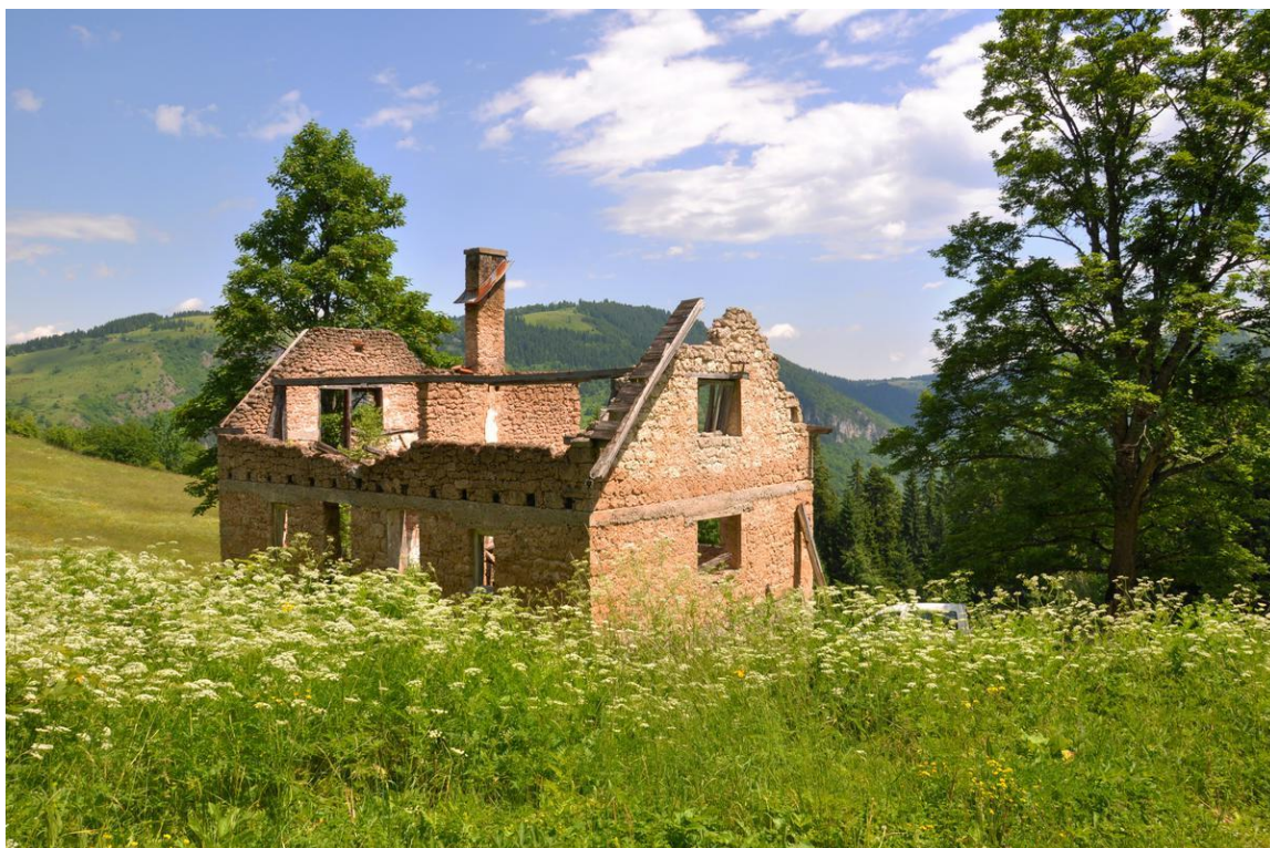
Obr. 8 Opuštěný dům v pohoří Bukovik
